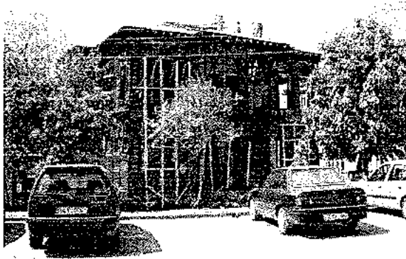
Resim. 57: Hafızağa Konağı (Onarım sırasında)
