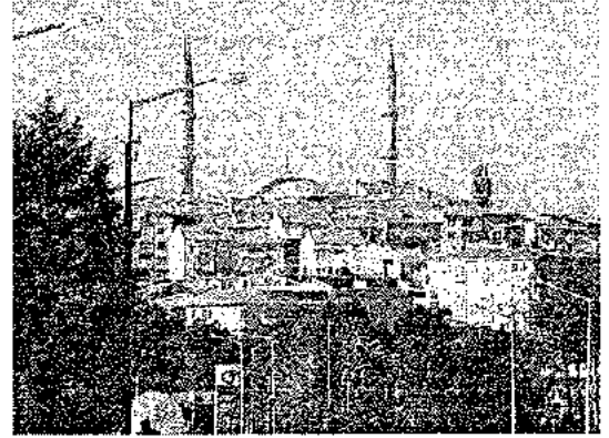
Resim. 30: İstanbul yönünden yaklaşımda Selimiye Camii'ni örten yüksek yapılaşma
